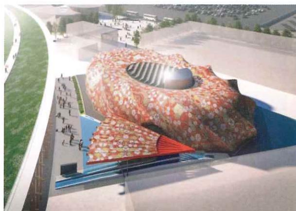
この建物は(設計は高松伸、施工は清水建設、西陣織は細尾、膜材の技術を持つ太陽工業の 4 社で世界初の西陣織建築に着手した)赤を基調とする花柄の西陣織がパビリオン表面の膜材となり、大きく波打つような 3 次元曲面の構造体を覆い尽くす。階数は地下 1 階地上 2 階建てで、高さ約 12m、西
